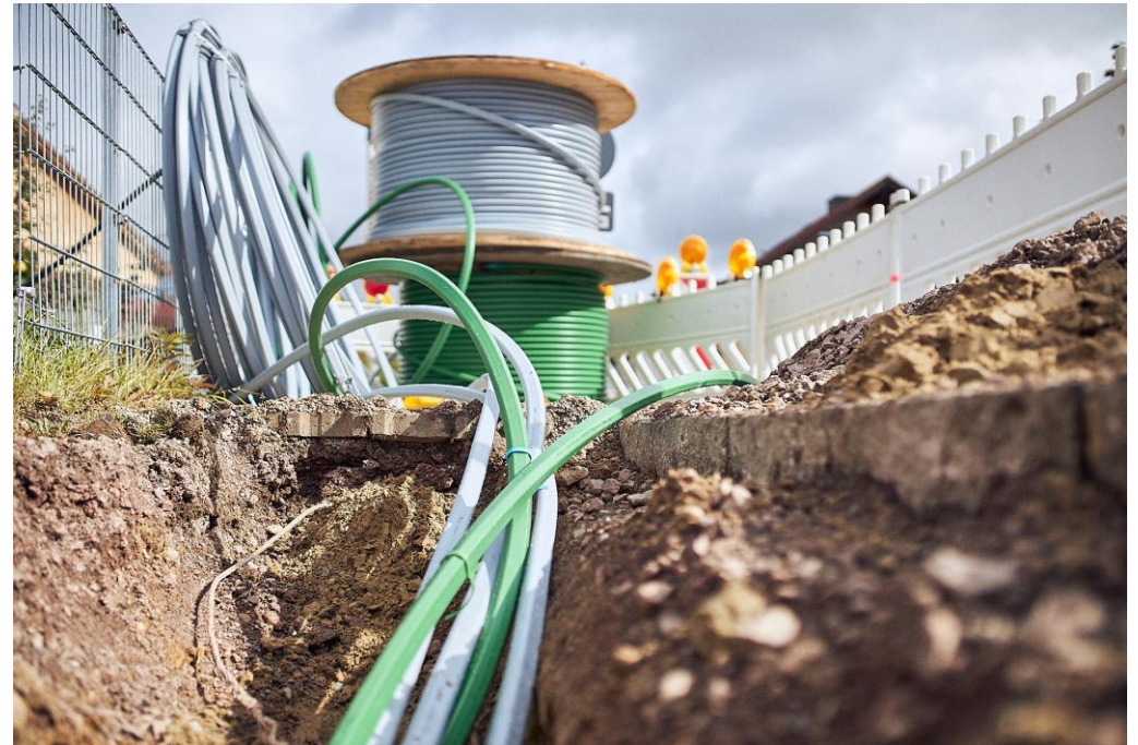
Eine Baustelle des Netzausbaus von Stiegeler IT Foto: Stiegeler IT
